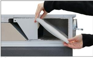
3. Retirer le filtre de l'appareil
