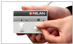
1. Éteindre l'équipement sur le panneau de commande avant d'ouvrir le capot
