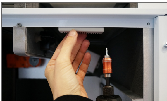
5. Montez la sonde de CO 2 sur le couvercle supérieur avec des vis autotaraudeuses. (fournies avec le kit de sonde de CO 2 )
