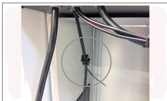
L'écarteur est fixé au câble LAN qui se trouve derrière la grande trappe.
