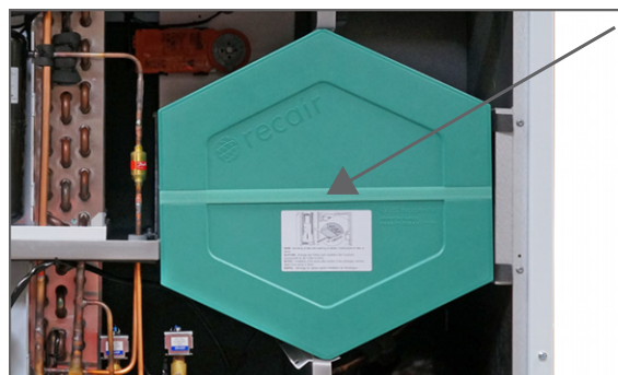
2. Démontez le commutateur en croix en tirant sur l'attache (il ne faut pas couper au-dessus d'elle).
