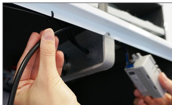
4. Faites passer le conducteur de la sonde de CO 2 par cette cavité.
